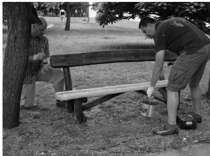
A szülők segítenek a kerti padok felújításában
