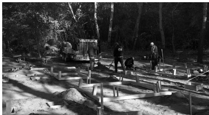
Megkezdődött az alapozás
