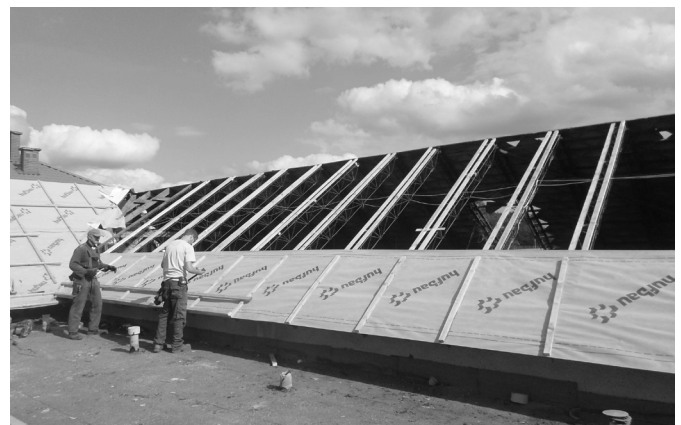
Az iskola épületszigetelése
