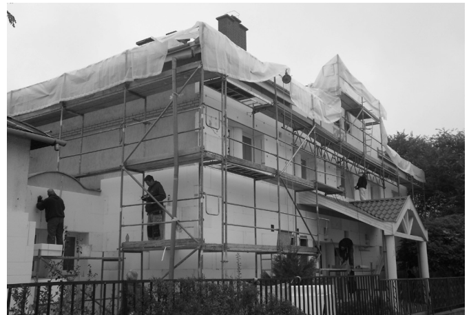
A tetőszigetelés előkészítése
